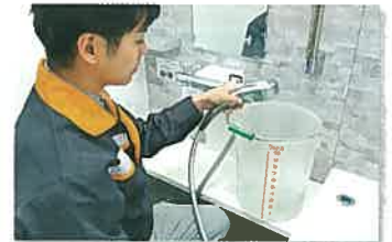
お湯の出ぐあいや出湯量などを確認
