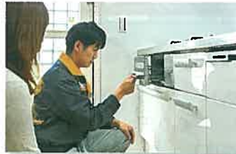
コンロの点火状況などを確認
